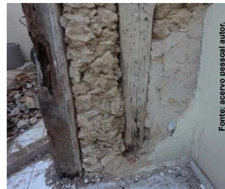
FIGURA 3 - Parede interna de taipa real.
