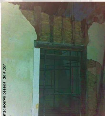
FIGURA 4 – Visão da parte superior da parede de taipa real.
