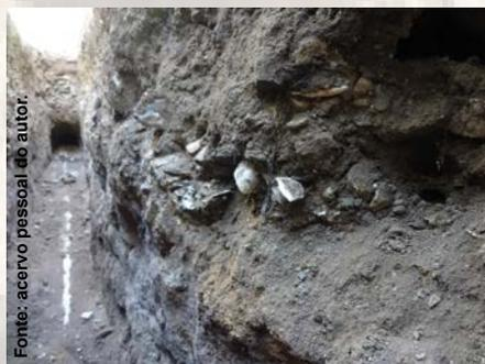
FIGURA 5 – Escavação das fundações de uma parede de taipa real, com visualização de várias conchas de ostras.
